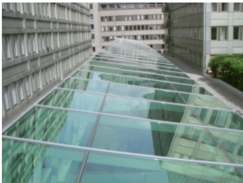
Hamngatsgallerian i Stockholm, nytt glastak. Arkitekt: Wester-Elsner
